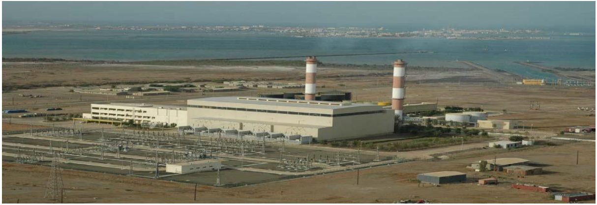
Hingigo (Massawa) Power plant( መመንጩዊ ጸዳት ባጽኑ )
